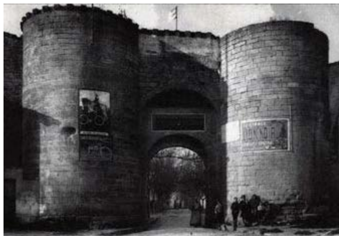
Localisation: Porte de la Condamine
